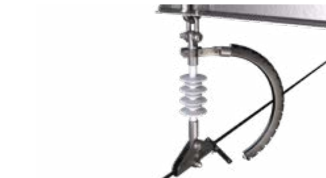
Рис. 12. Установка РМКЭ-10 совместно с подвесной полимерной изоляцией
