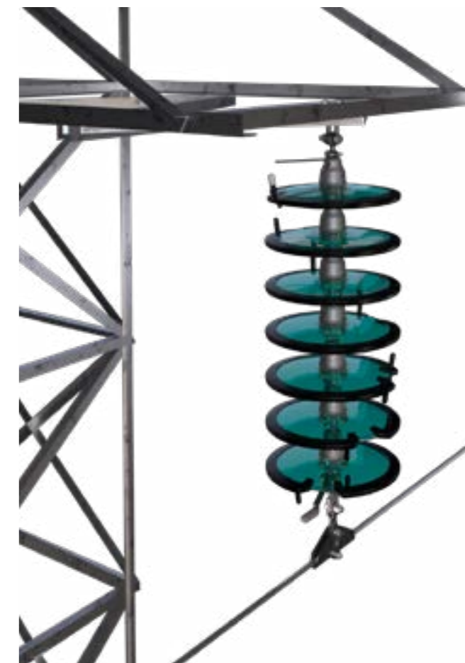
Рис. 25. Установка ГИРМК-110 на промежуточной опоре
