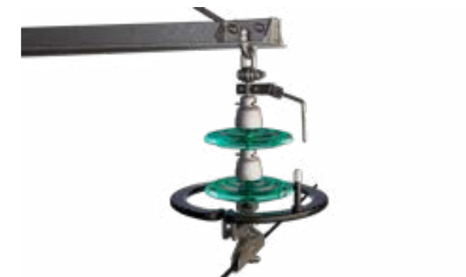
Рис. 15. Установка РМКЭ-20 совместно с подвесной стеклянной изоляцией
