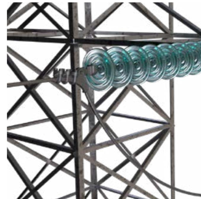
Рис. 25. Установка ГИРМК-110 на промежуточной опоре
