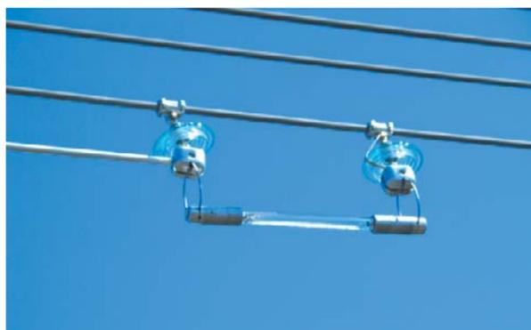
➤ **Защитные кожухи, установленные на изоляторы для предотвращения гибели птиц на ВЛ**
