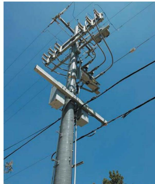
➤ *Композитная опора ВЛ производства RStandard с установленными вакуумным реклоузером и выключателями*
