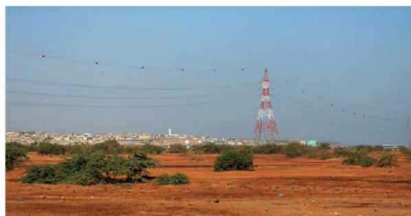
➤ *Дневная маркировка опор и проводов ВЛ на местности в пределах воздушных трасс: опоры окрашены контрастными полосами красного и белого цветов, на грозотросе установлены шары-маркеры*
