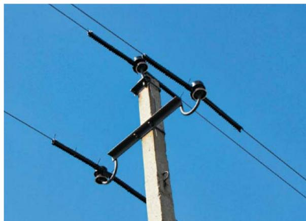
➤ *Средство ночной маркировки проводов ВЛ – бализор*
