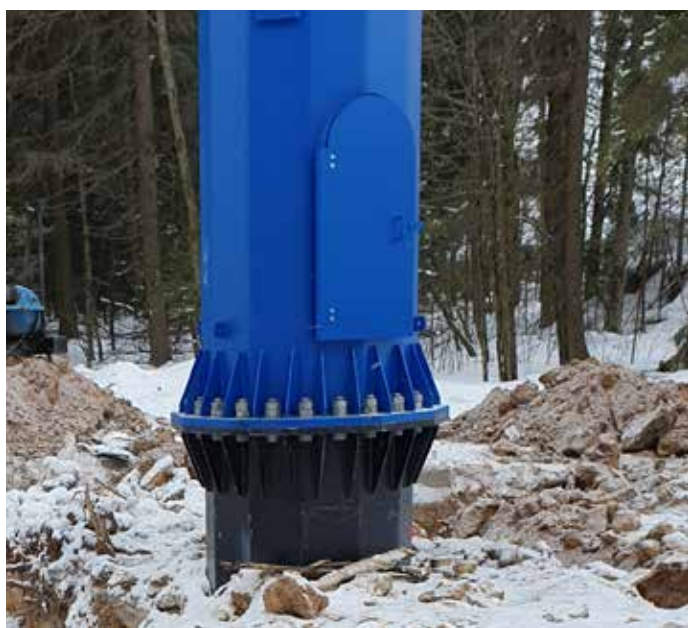
Фундамент свая-оболочка, люк для подъёма на эксплуатационную площадку внутри ствола опоры
