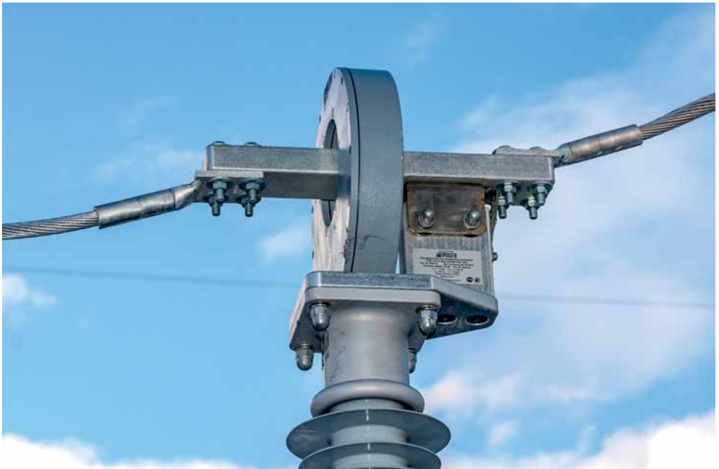
Оптический трансформатор тока для организации селективного АПВ
